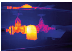
Проверка функциональности паропроводящих труб
